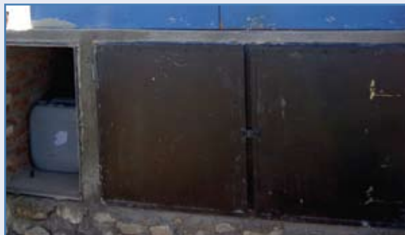
Foto 10: puertas metálicas de la base
