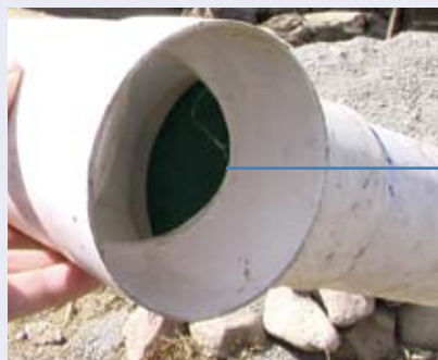
Foto 16: Tubo de ventilación con malla protectora.
