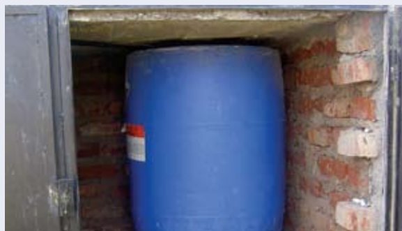
Foto 17: Contenedor de heces
