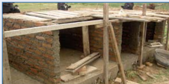
Foto 5: Encofrado para vaciar la loza
