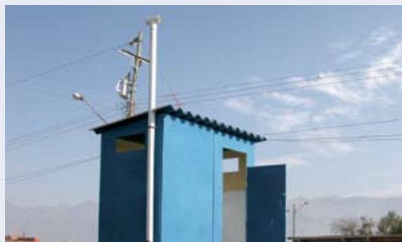
Foto 15: Caseta con tubo de ventilación (blanco)
