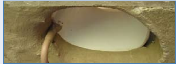
Foto 7: Hueco para taza de baño
