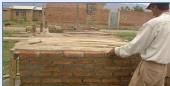
Foto 6: Encofrado para vaciar la loza
