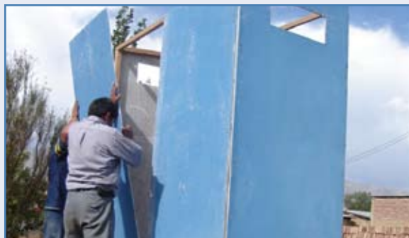
Foto 10: puertas metálicas de la base
