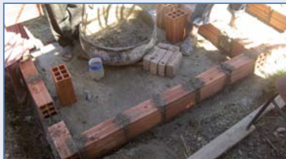
Foto 4: Elevamiento de paredes sobre cimiento.
