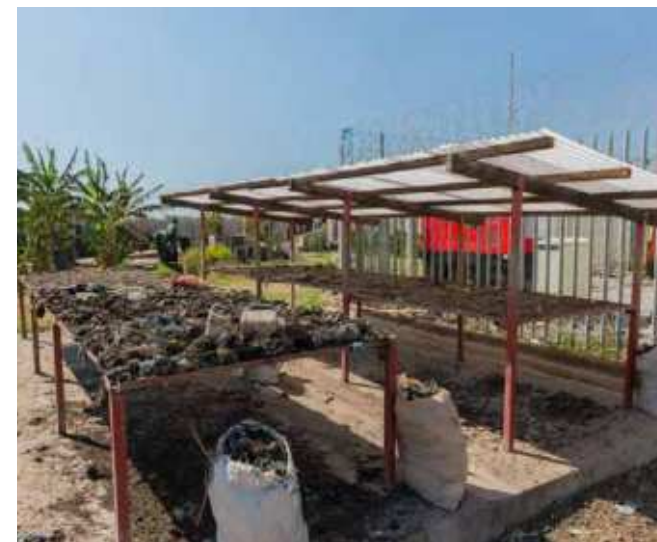
Clasificación y secado de residuos sólidos en la FSTP de Kanyama
