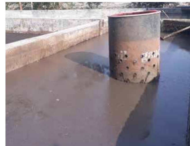
Los lodos sedimentados pasan al lecho de secado natural a través de la compuerta de filtración
