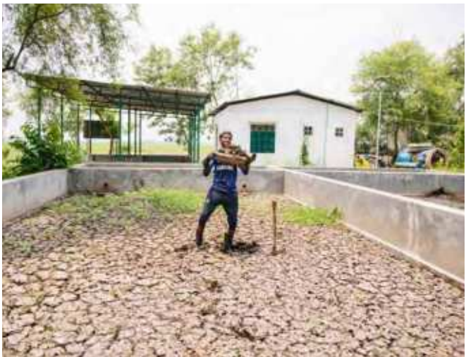
Retirar los lodos secos de los lechos de secado
