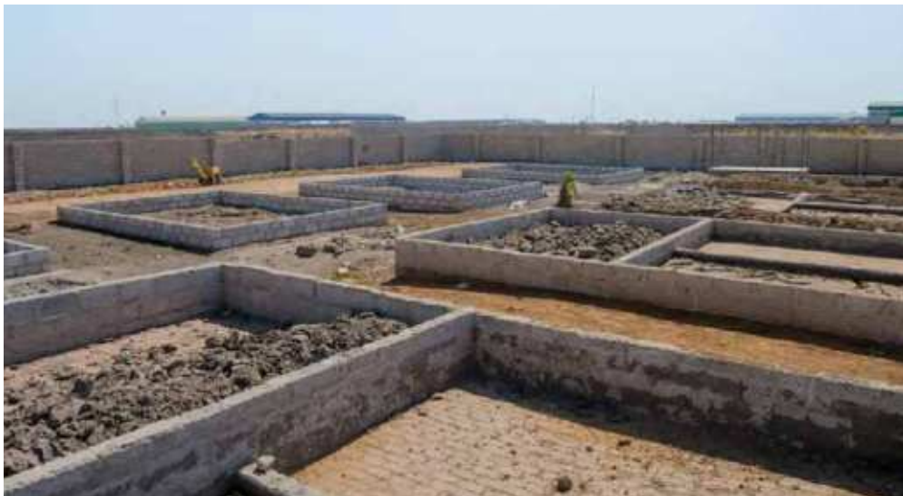
Los lechos de secado de lodos de la FSTP de Kanyama se desmantelan
