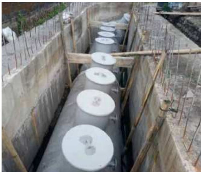
Instalación de la tecnología DEWATS
