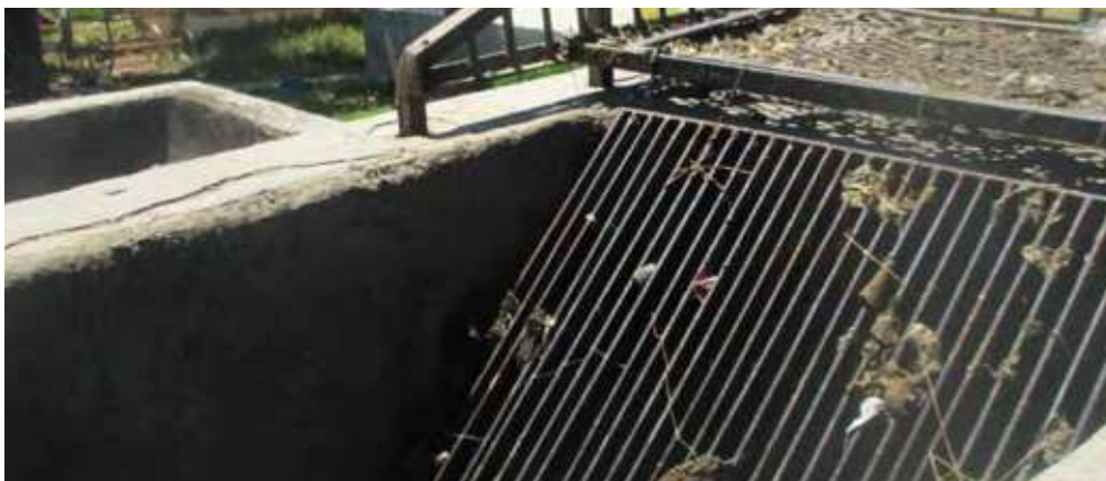
Chazanga FSTP separación de arenas en el punto de descarga del afluente
