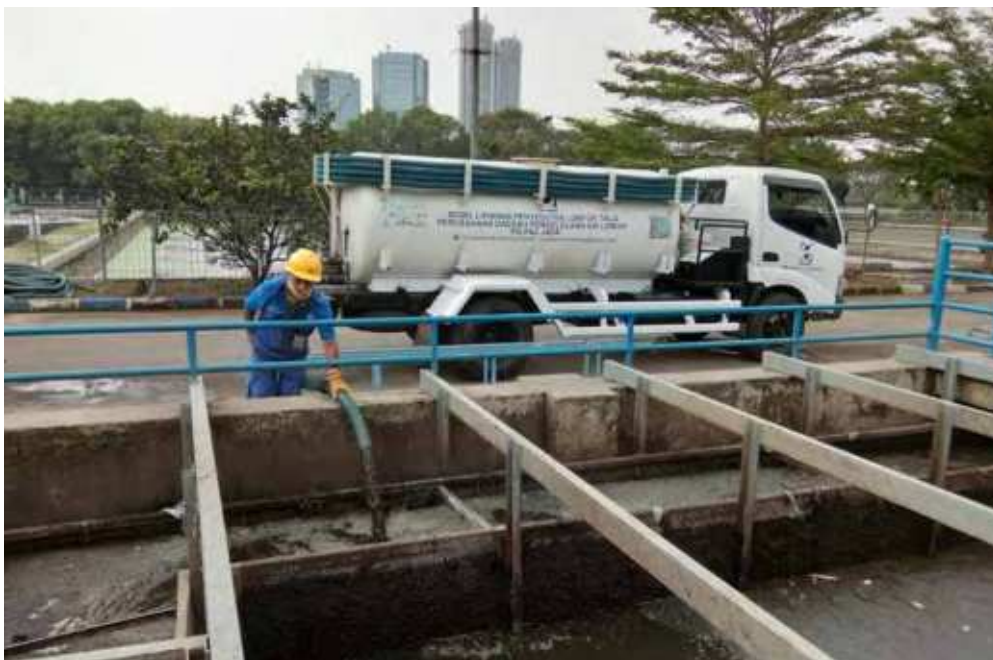
Estanque aeróbico convencional
