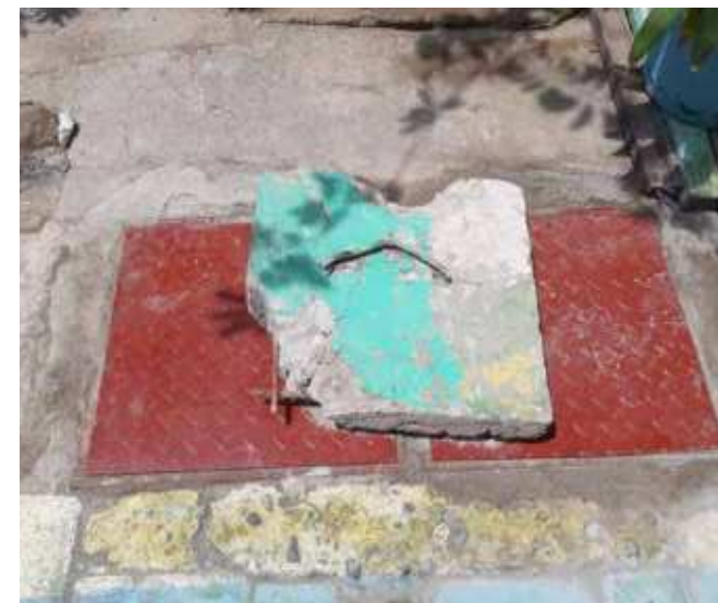
Comparação da cobertura de concreto e de ferro leve para a cobertura da câmara de inspeção
