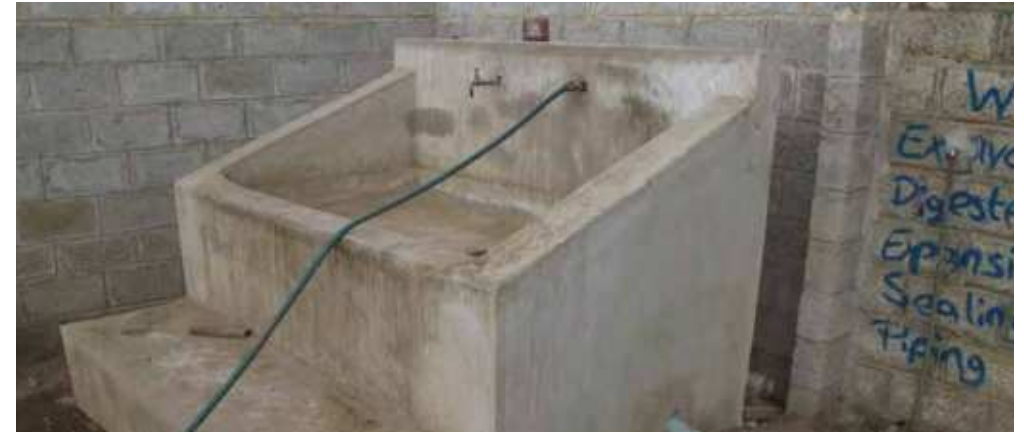
Balde de lavagem para limpeza de barris em Kanyama FSTP
