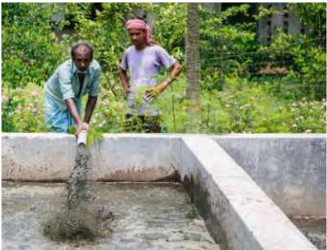
Descarga de lodo em leitos de secagem
