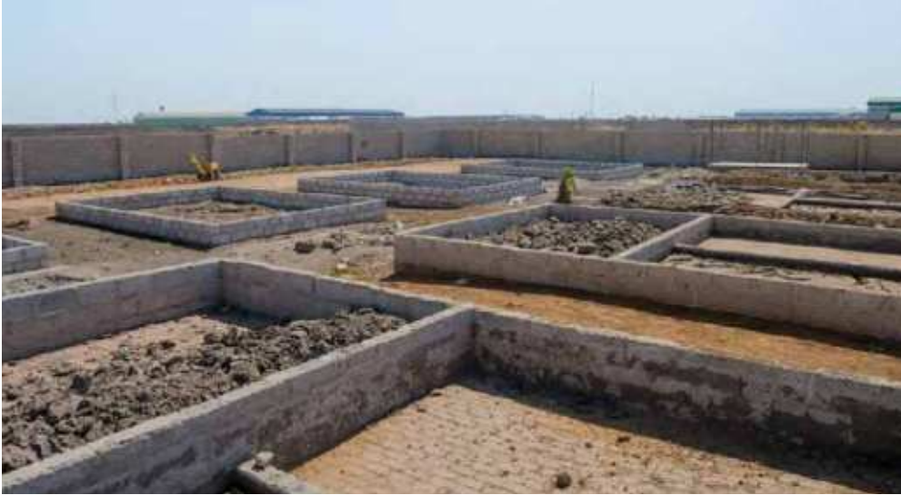
Os leitos de secagem de lodo de Kanyama FSTP são desmontados
