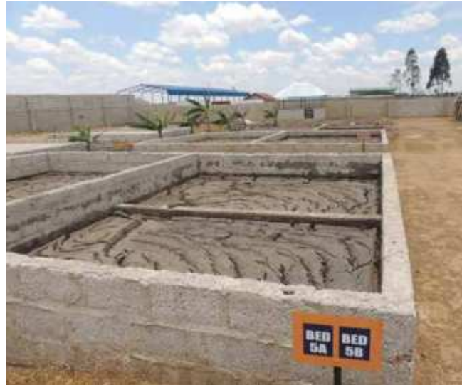
Camas de secagem revestidas mas não cobertas em Kanyama FSTP
