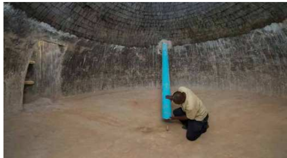
Digestor de biogás Chazanga interior
