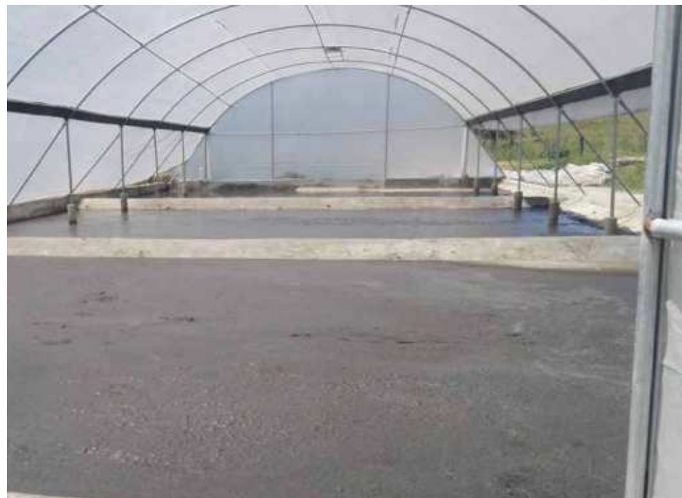
Secador solar nas instalações de NAWASSCOAL
